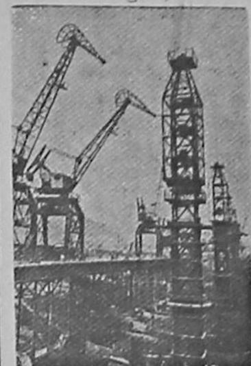
На строительстве Куйбышевской гидроэлектростанции устанавливаются телескопические краны высотой 67 метров с вылетом стрелы 40 метров для монтажа гидротурбин и гидрогенераторов. На снимке: монтаж башен новых телескопических кранов.
